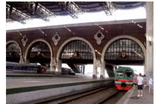
Railway stations Железнодорожные вокзалы
